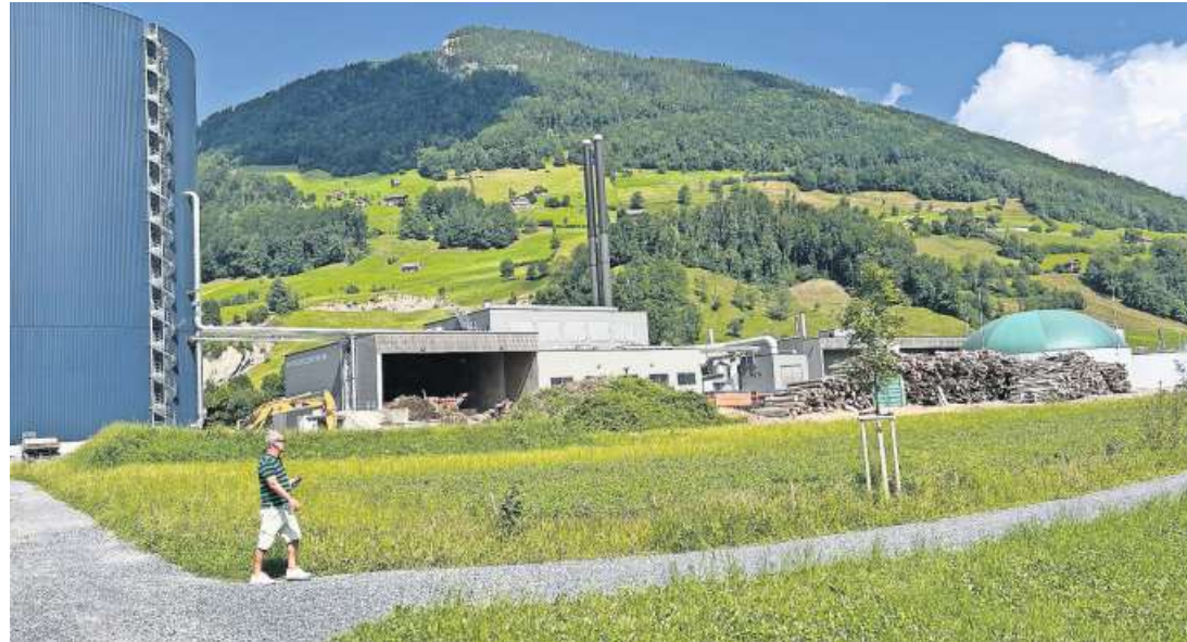
Die Anlage der Agro Energie Schwyz AG.
